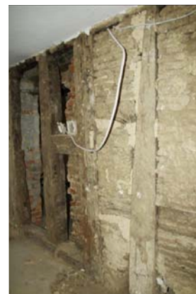
Ein baugeschichtlich wichtiges Wanddetail
