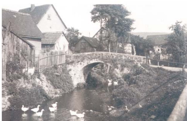
Historische Aufnahme des Brückelchens aus der Chronik Gengnagel (vor 1937)
