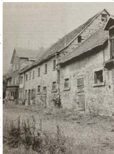
Gutshof und Wirtschaftsgebäude – (c) Gießener Anzeiger 1974
