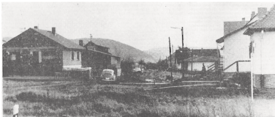
Mitten durch das Neubaugebiet wird die neue Ortsdurchfahrt in Alten-Buseck führen
