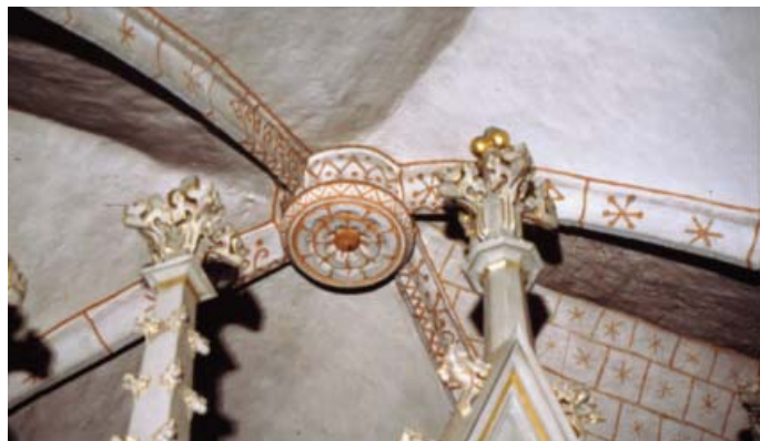
Spätgotisches Rippengewölbe im Querhaus.
